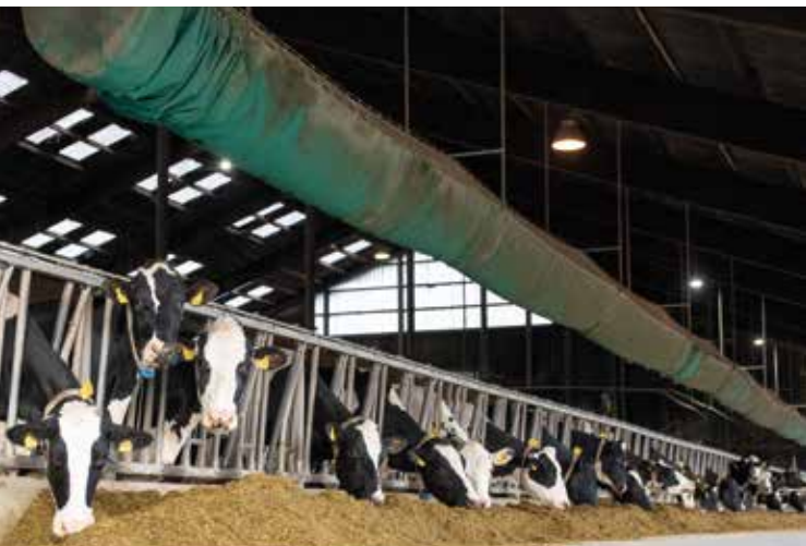
Für ein gutes Stallklima bei den Melkenden sorgen Belüftungsschläuche
